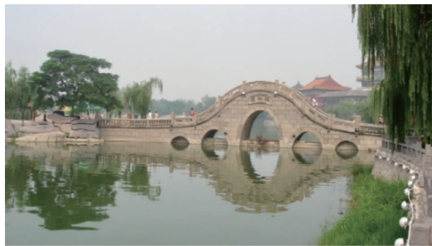
图10 开封龙亭湖景区拱桥
