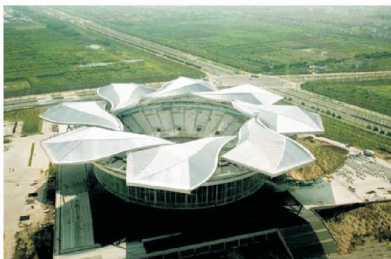
构件仿生——网球中心屋面
