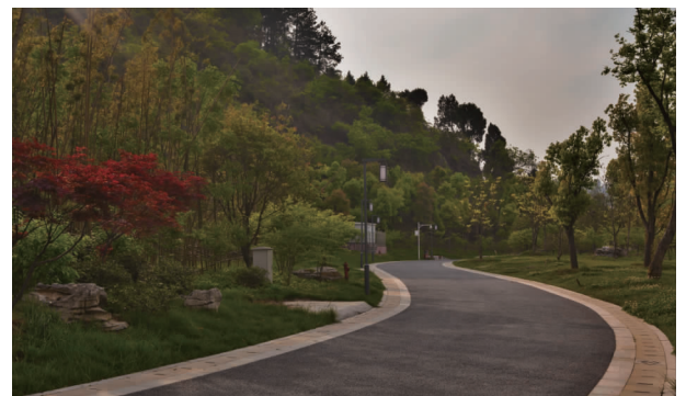
图15 路面铺装施工效果
