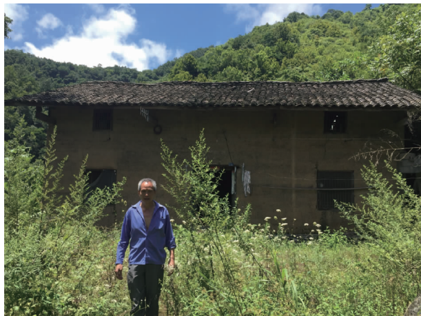
图 1 土木结构房屋
