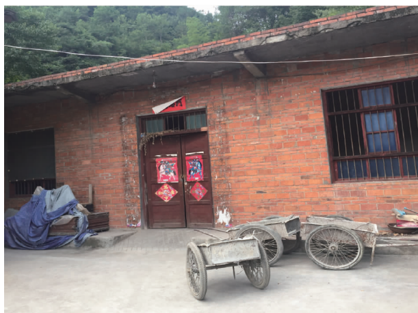
图 3 砖混结构房屋
