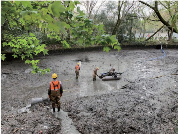
图3 底泥冲刷及泥泵吸泥
