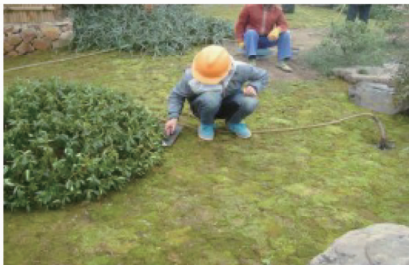
图6 人工拍打压实苔藓
