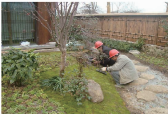
图6 人工拍打压实苔藓
