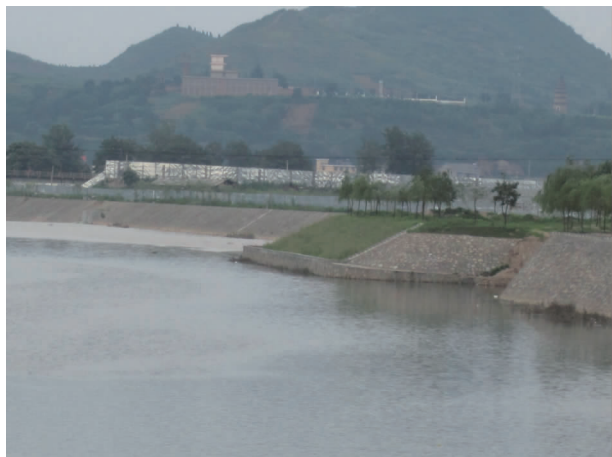
图3 商洛市丹江河床冲毁情况
